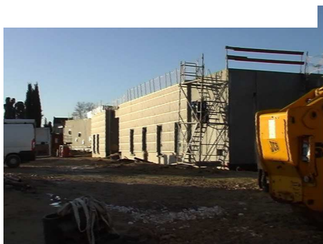
L'école façade Est
