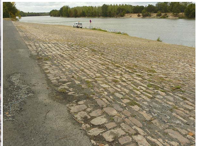
Ancienne cale le long de la Loire
