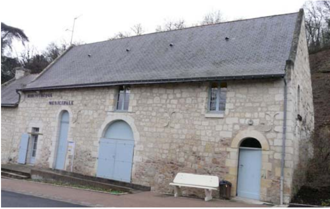
Château de la Roche, dépendance
