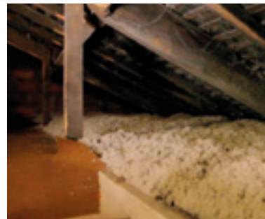
Les combles : à isoler en priorité !
